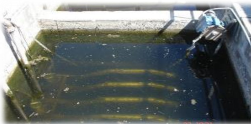
Εικόνα 3: Απολύμανση με υπερύθρη ακτινοβολία (UV) εκροής εγκατάστασης επεξεργασίας αστικών λυμάτων
