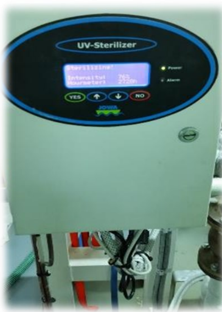
Εικόνα 3: Σύστημα UV με κλειστό κανάλι για απολύμανση πόσιμου νερού σε εμπορικό πλοίο.
