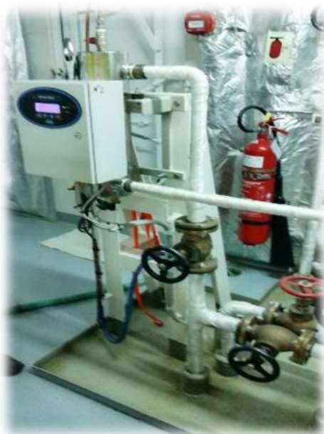
Εικόνα 3: Σύστημα UV με κλειστό κανάλι για απολύμανση πόσιμου νερού σε εμπορικό πλοίο.
