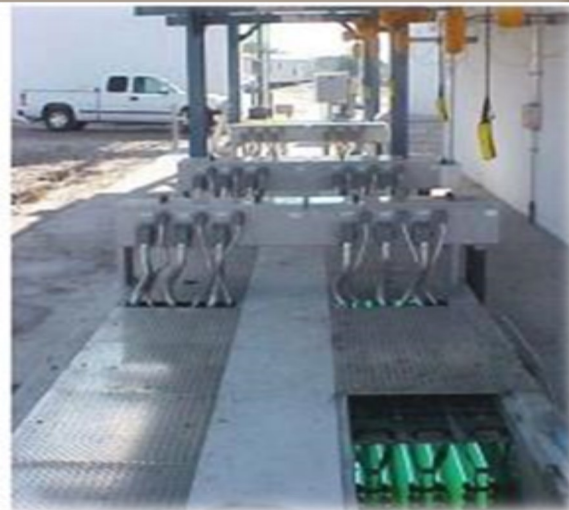
Εικόνα 1: Παραδείγματα UV Αντιδραστήρων : (α) Κλειστό κανάλι και (β) σε ανοικτούς αγωγούς Πηγή USEPA UV Disinfection Guidance Manual November 2006 Source: (a) Courtesy of Calgon Carbon Corporation and (b) Courtesy of WEDECO UV Systems
